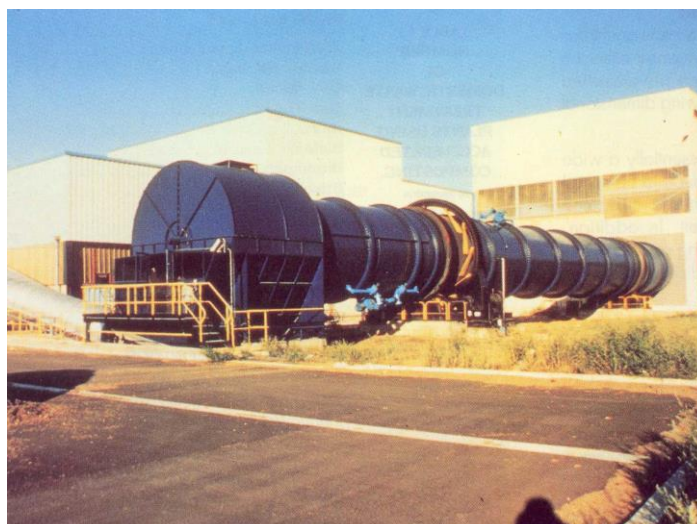
Figura 11.39 Vederea unei instalatii de compostare dinamica cu tambur de alterare
