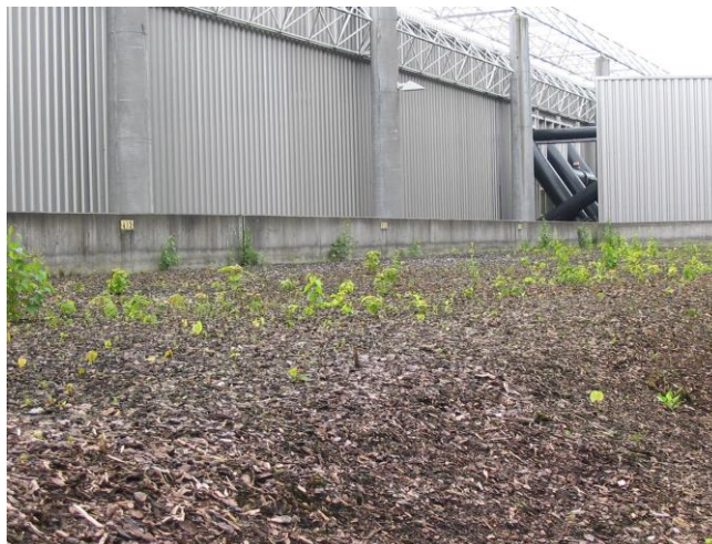
Figura 11.28. Vedere biofiltru utilizat la o statie de compostare
