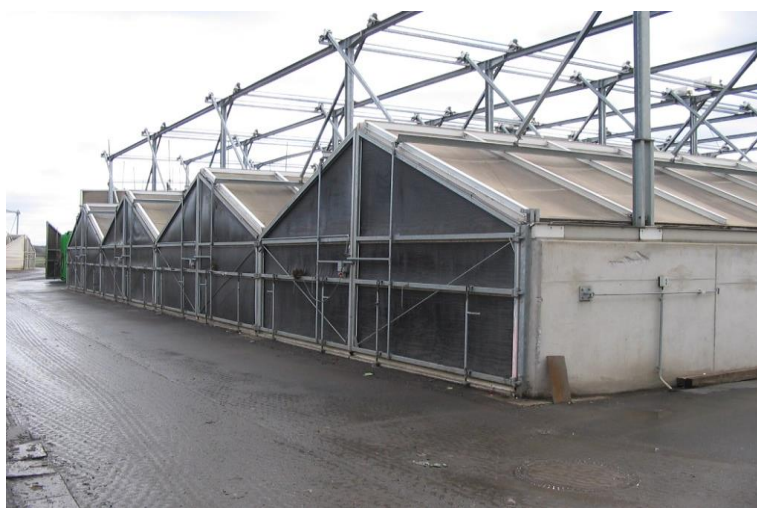
Figura 11.37. Exemplu de celule de compostare
