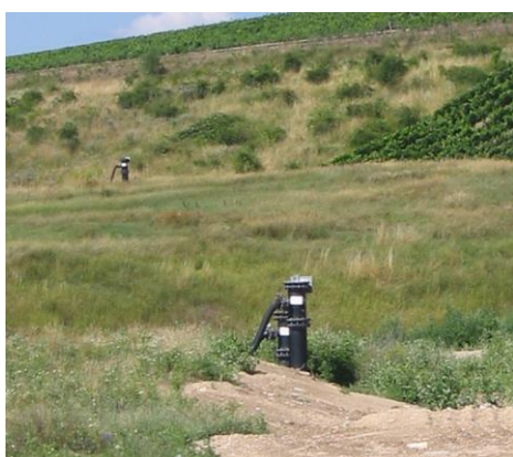
Figura 13.7 - Put și sistem de colectare a gazului de depozit
