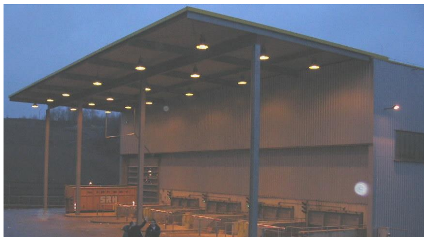
Figura 11.44. Zona de livrare deseuri
