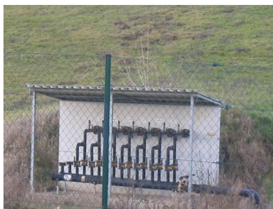
Figura 13.7 - Put și sistem de colectare a gazului de depozit
