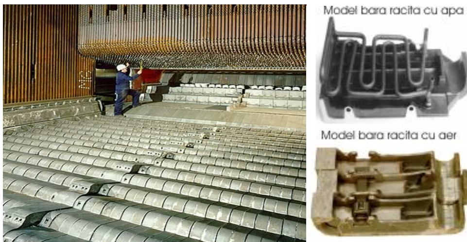
Figura 11.55. Vedere cuptor cu gratar
