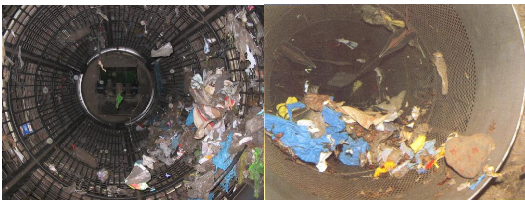
Figura 11.10. Vedere in interiorul unei site tambur (cutite pentru desfacerea sacilor de deseuri)
