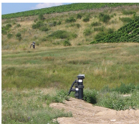
Figura 7.7 - Put si sistem de colectare a gazului de depozit
