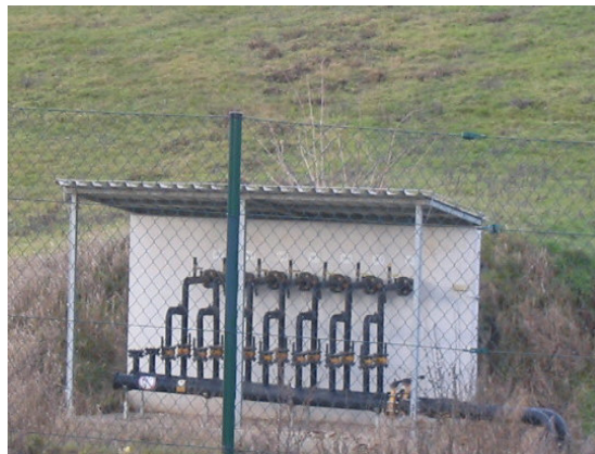
Figura 7.7 - Put si sistem de colectare a gazului de depozit
