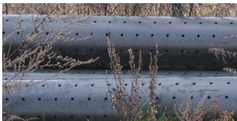
Figura 7.5 - Vedere tevi de colectare a levigatului
