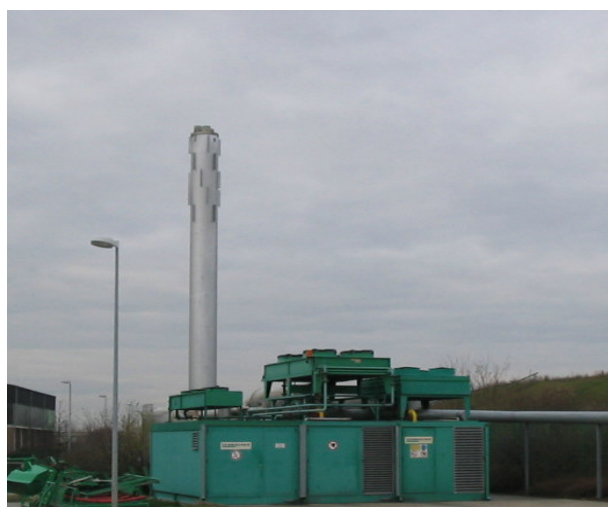
Figura 7.8 - Sistem de valorificare a gazului de depozit
