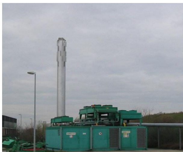
Figura 7.8 - Sistem de valorificare a gazului de depozit
