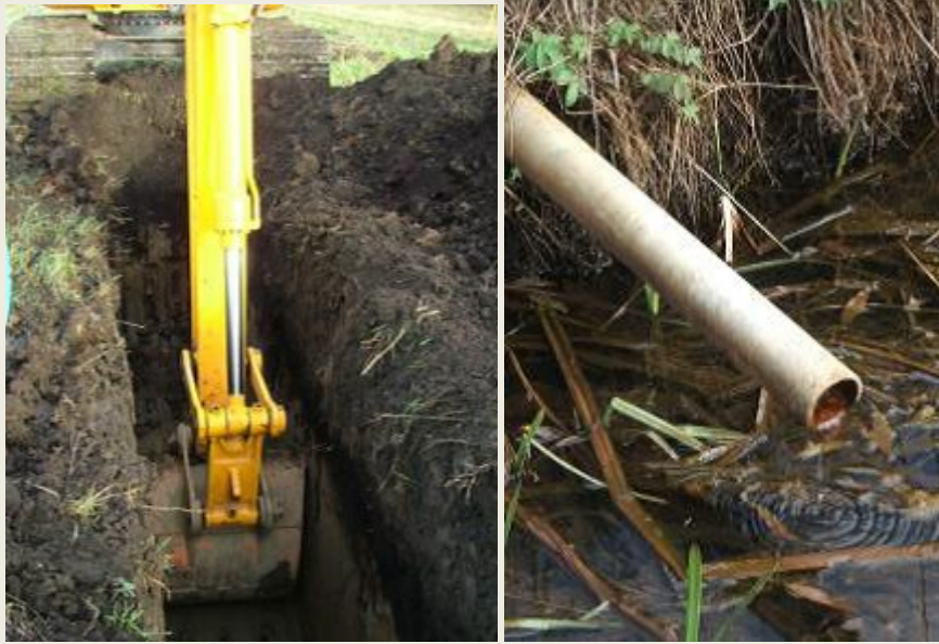
Figura 12 Gropi de exploatare și canalele de drenaj
