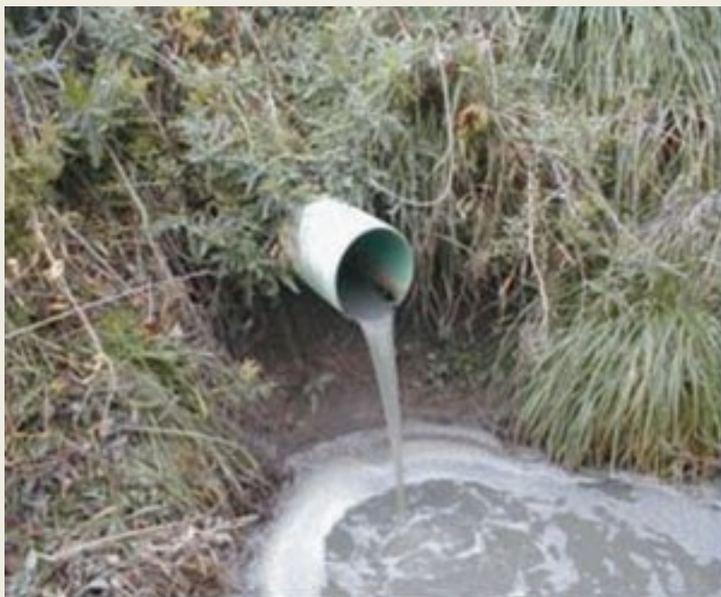
Figura 10 Gură de evacuare a apei colectate din solurile de adancime ale unei foste zone umede
