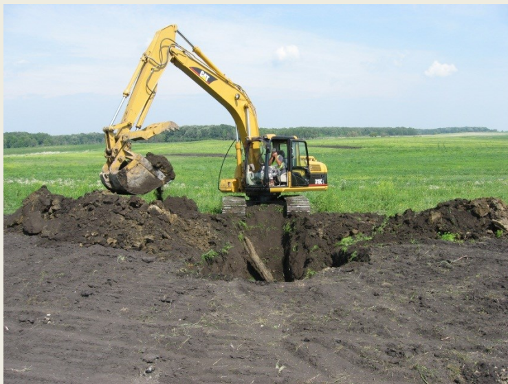
Figura 9 Înlăturarea materialului de umplutură pentru refacerea unei zone umede în Windy Lake, Minnesota Foto: Rod Marsh, Minnesota, SUA.
