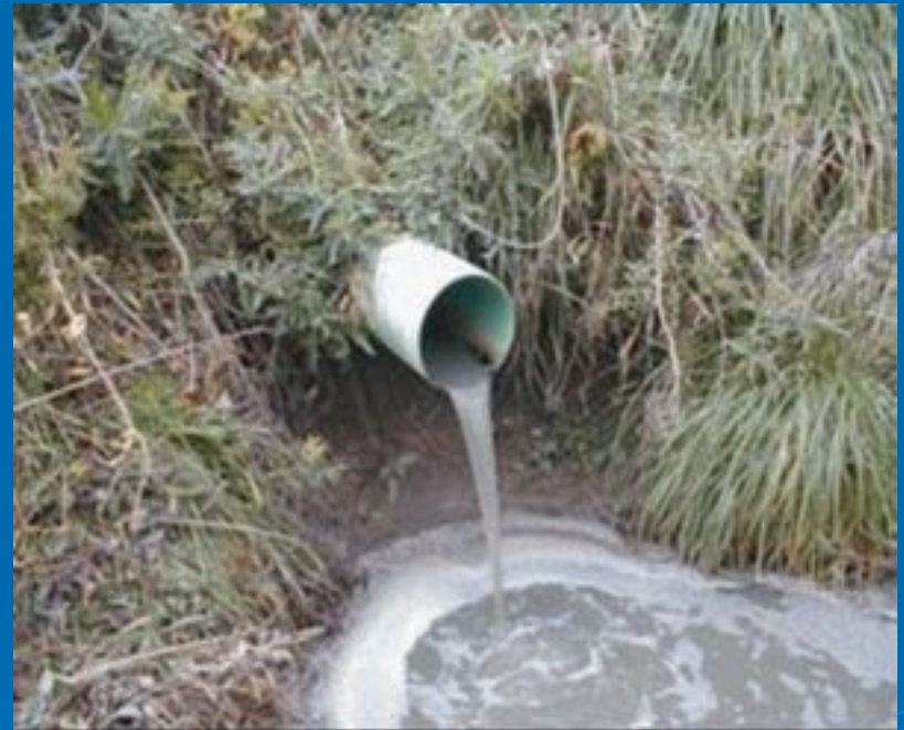
Gură de evacuare a apei colectate din solurile de adancime ale unei foste zone umede
